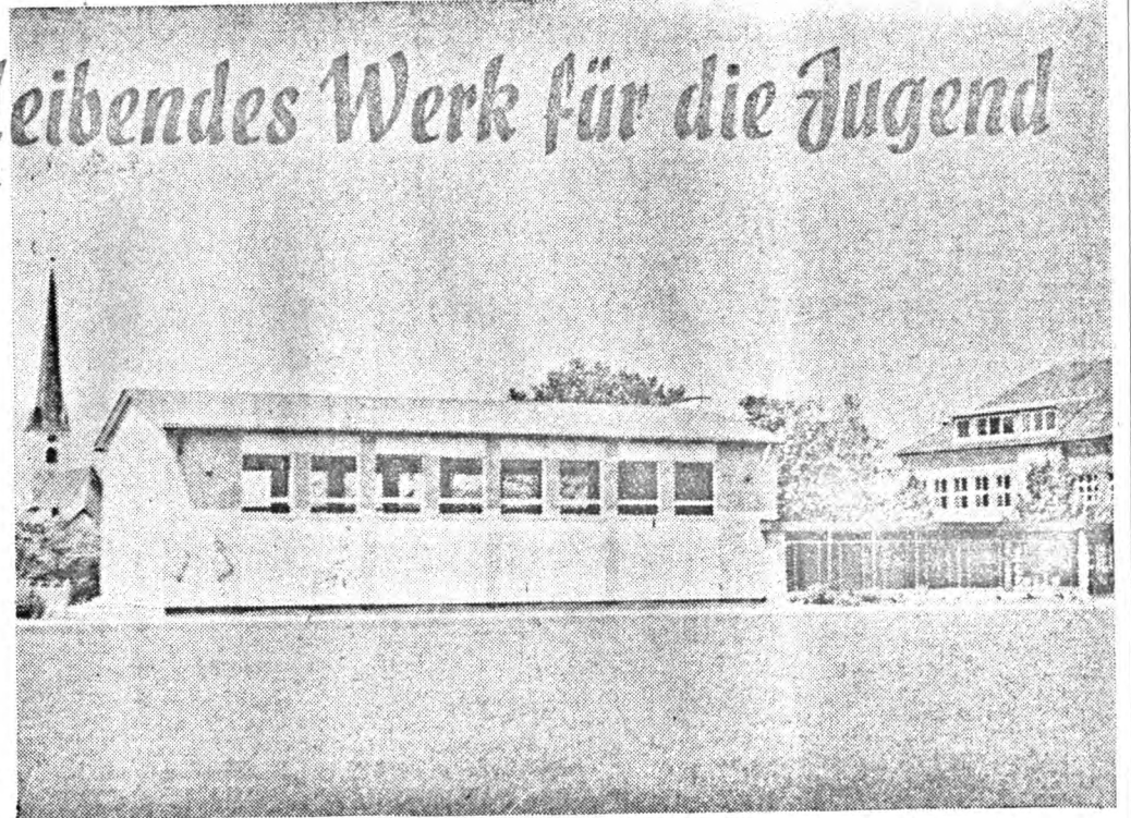
Die neue Turnhalle von St. Georgen, vom Fußballplatz aus gesehen. Eine Pausenhalle aus Stahlkonstruktion nach Ost und West isoliert verglast verbindet sie mit dem Schulhaus. Links im Bild die Pfarrkirche von St. Georgen.
