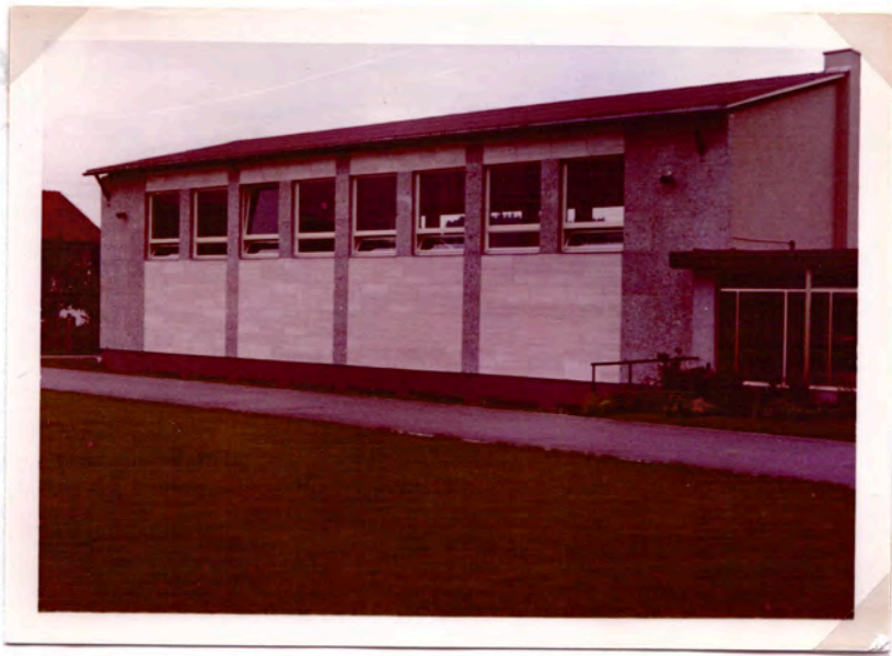
Ansicht der Turnhalle
