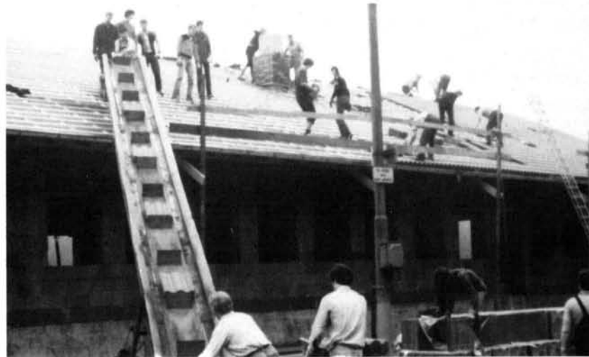
Freiw. Helfer beim Bau des Sportheimes (Dachdeckerarbeiten im Sept. 1980)
